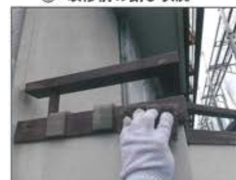
③ ケレン（下地処理）
