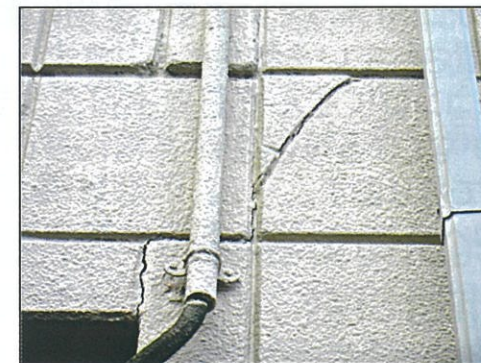
①外壁クラック処理
