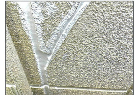
②クラック箇所シーリング
