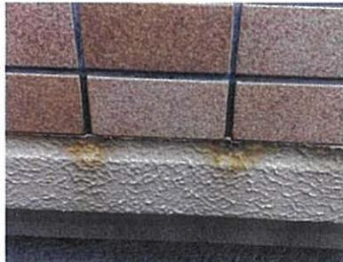
コンクリート内部の鉄筋の錆が発生・膨張し、コンクリートを押し出しで破壊されている
