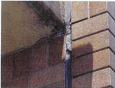
放置しておくと、大気中の炭酸ガスや水の侵入によりコンクリートの中性化促進
