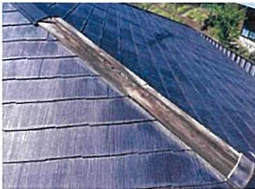
屋根の棟と言われる部分の金物がはがれ落ち、下地が腐食している状況です。
