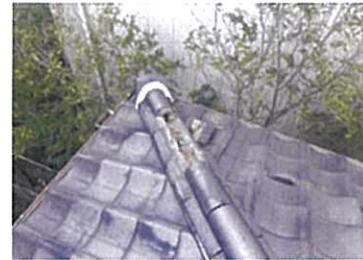
屋根の棟瓦が強風で欠落してしまっている状況です。
