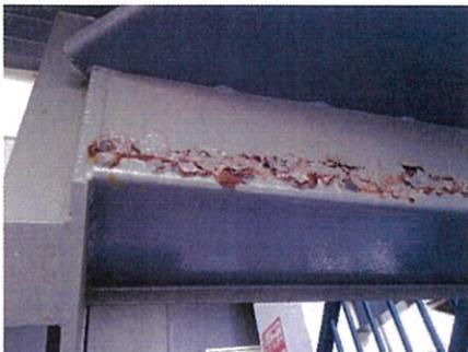
鉄が腐食して塗装が剥がれる
