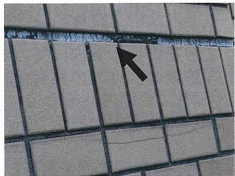
打継目地の変色とひび割れ
