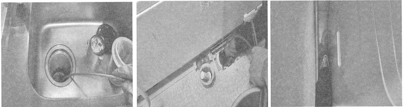
上記右側写真は、洗濯排水の清掃写真です。写真の様に洗濯機とお客様の棚の間の狭い所に手を伸ばしホースを入れています。
