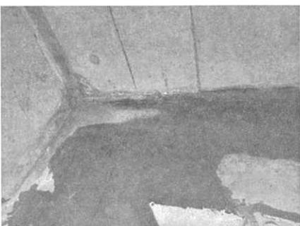
コンクリート打継の漏水
