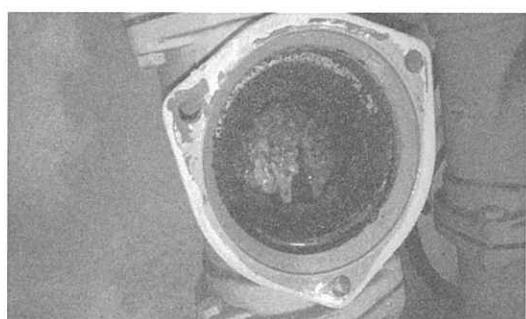
上記左側写真は、配管内から尿石が出てきました。右側写真は配管内が鉄錆と油の塊で塞がっていました。
