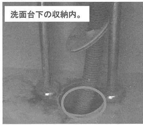
マル印の排水管の接続部分が洗面台の床下にあり、接続ゴムパッキンの劣化や、外れていることがあります。
