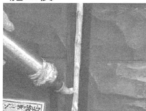
目地シールの打ち替えを行い、漏水や外壁のひび割れを防止します。場所により、増し打ちなど施工方法を変えています。
