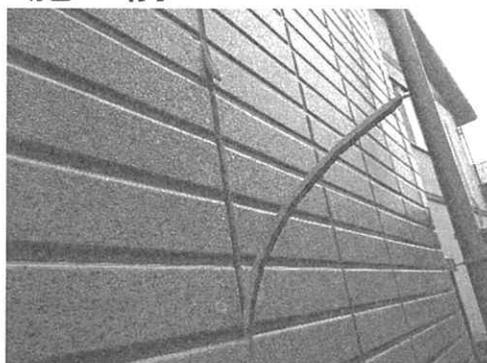
紫外線などで外壁目地シールが劣化すると、漏水や外壁のひび割れの原因となります。定期的なメンテナンスが必要です。
