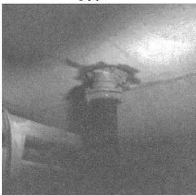
鉄管の排水管が詰まり、漏水した可能性があります。浴室天井から確認
